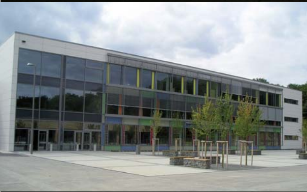
Nouveau concept, nouveau bâtiment, nouveaux systèmes : le lycée Atert à Redange
